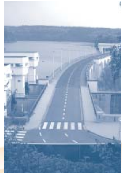
Die Staumauer der Eupener Talsperre
